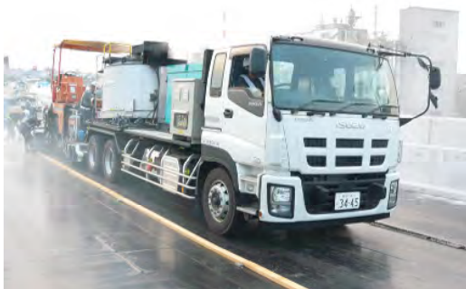
写真-6 施工状況
