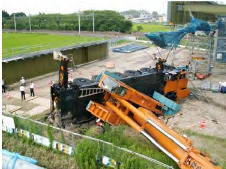
写真1 移動式クレーンの転倒事故
