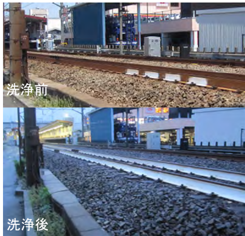
写真-11 洗浄前後の状況
