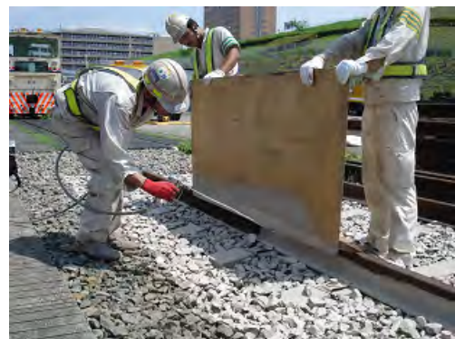
写真-3 人力による塗布施工例
