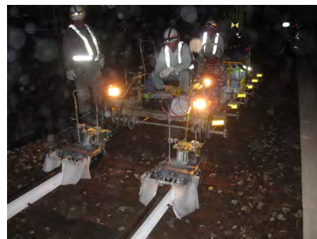
写真-8 塗布機による施工状況
