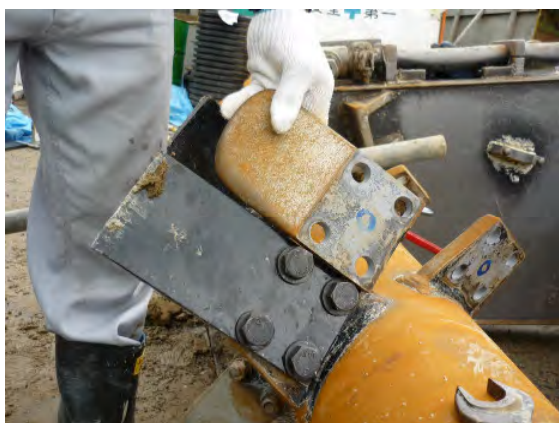
写真-9 DAM 機の攪拌羽根交換状況
