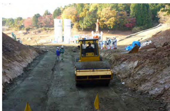
写真-6 振動ローラによる転圧状況
