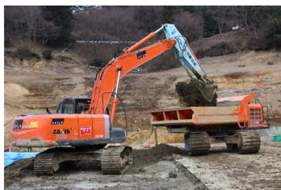
写真-4 初期固化土の解砕・積込状況
