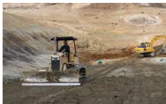
写真-5 解砕土の敷均し状況
