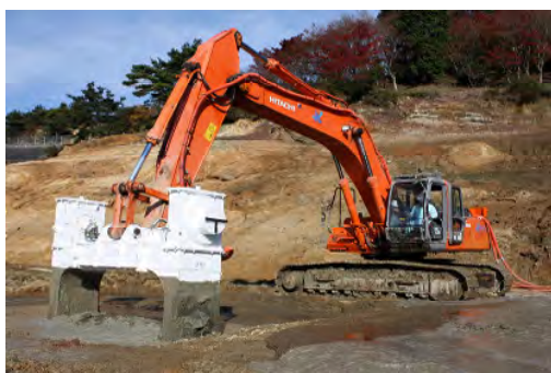
写真-2 DAM 機による初期固化状況
