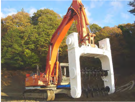
写真-8 DAM 機取付状況
