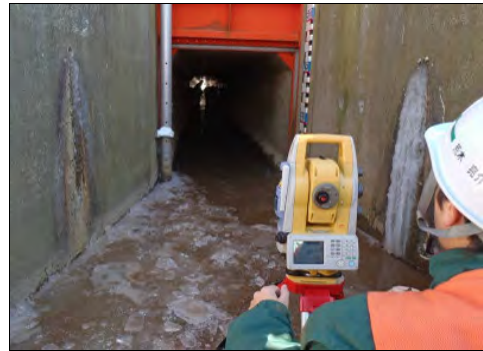
写真-7 函体内の変位計測装置をTSで視準している状況
