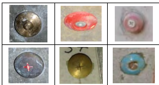
写真-14 実樋門に設置されている測定鉈
