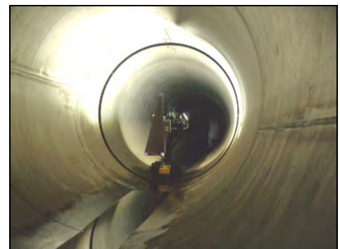
写真-9 樋管函体内 (内径 1.6m) 計測状況
