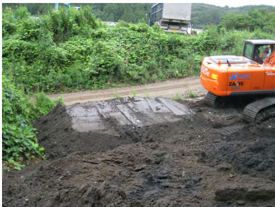
図-7 ショベルによる改良土の転圧
