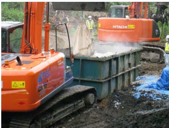
図-6 セメント系固化材の添加
