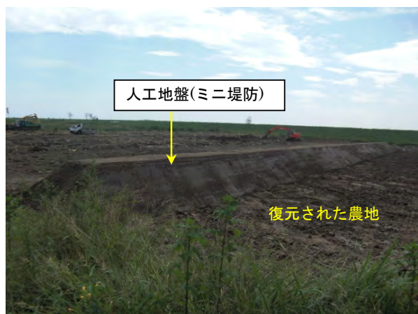
図-15 施工後の現場の様子（仙台市若林区藤塚）
