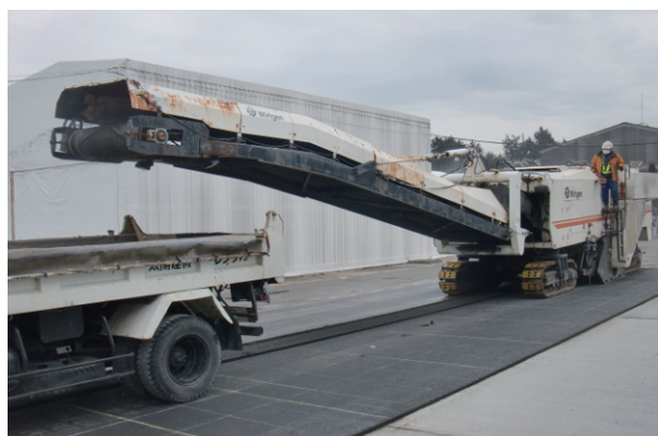
写真-11 大型切削機
