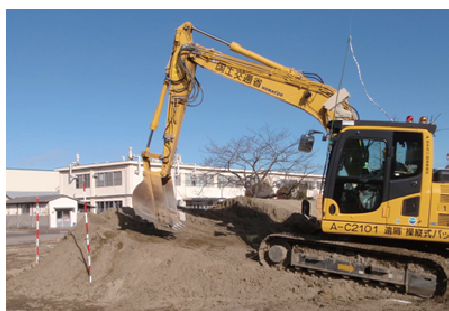
写真-4 進入路造成試験実施状況
