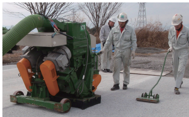
写真-13 スチールショットブラストによる表面処理
