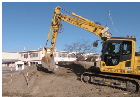
写真-4 進入路造成試験実施状況
