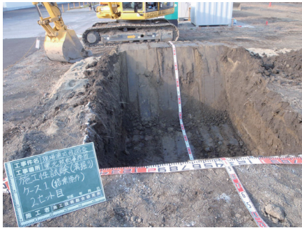
写真-5 排水路掘削試験実施状況 (掘削完了時)
