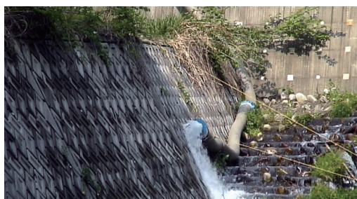
図-6 「呼び水」で排水ホースを満水にする
