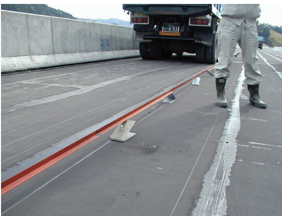
写真－1 アングルによる複数レーンの施工状況
