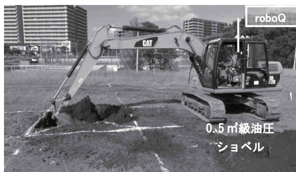
図-11 千葉県側掘削・積み込み実験状況
