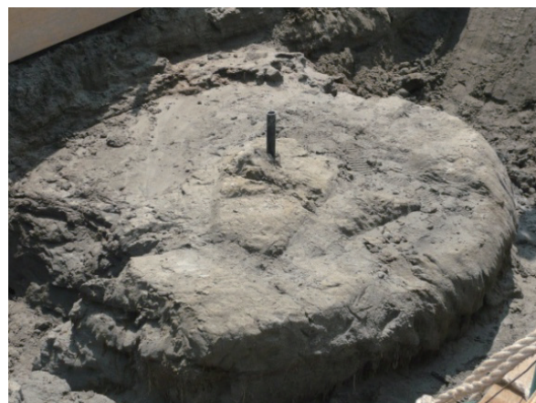
写真-1 改良体発掘全景
