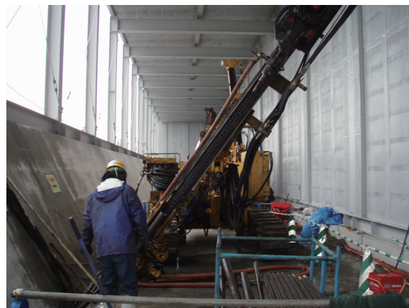
写真-2 削孔状況（防音壁内）
