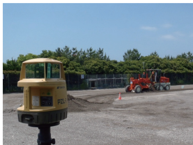
写真-4 施工状況（ゾーンレーザ）
