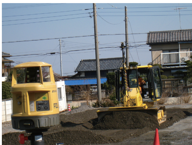
写真-2 施工状況
