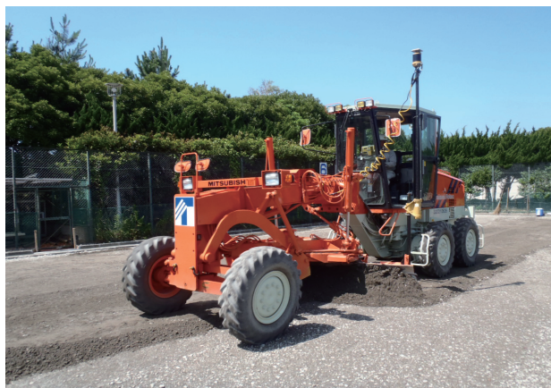
写真-3 施工状況（材料敷き均し）
