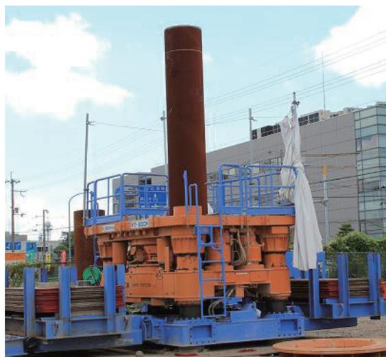
写真-1 直杭基礎の施工状況
