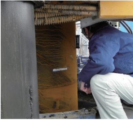
写真-3 傾斜計による杭の傾斜角の計測風景
