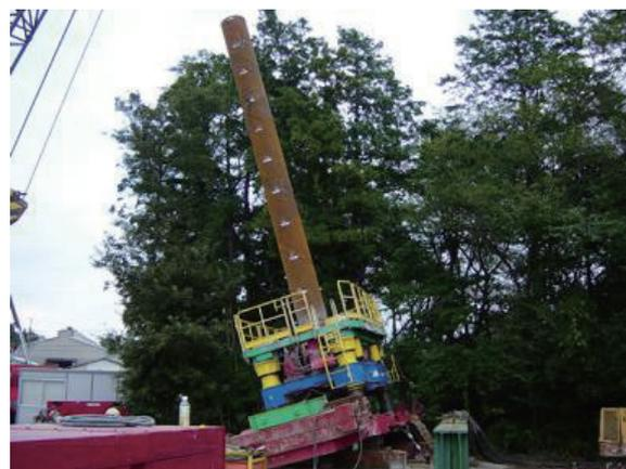
写真-2 斜杭基礎の施工状況
