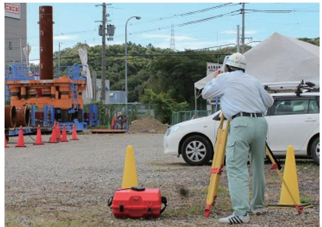
写真-5 Baum 内蔵 TS を用いた基礎杭の計測風景
