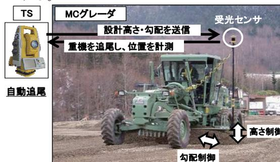
図-1 MC グレーダ施工状況
