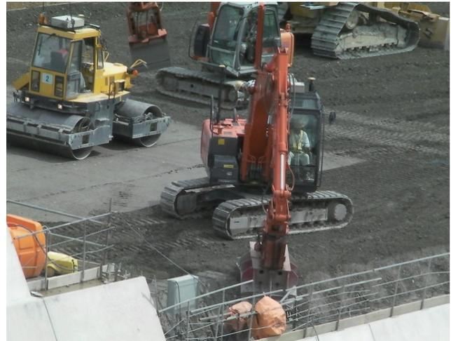
写真-3 端部法面締固め実施状況
