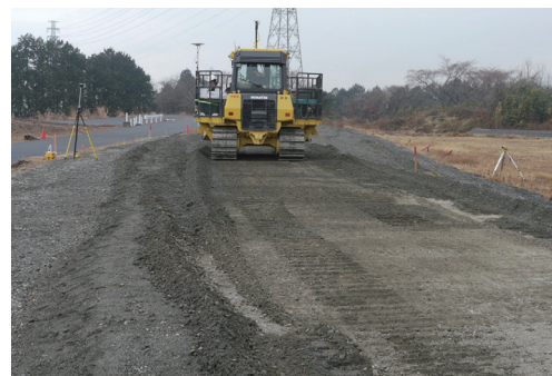
写真-7 みちびき RTK による敷均し状況
