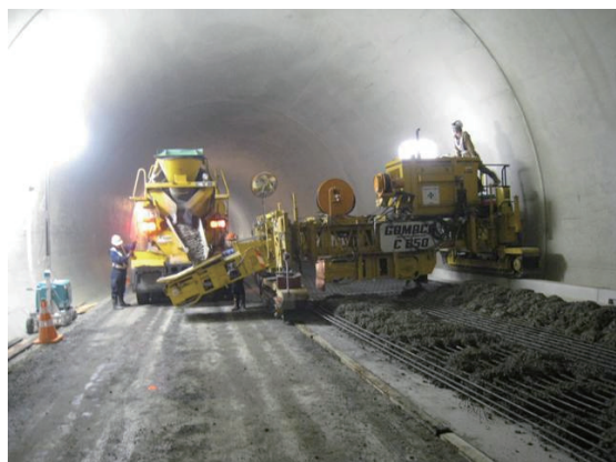
写真-7 施工状況
