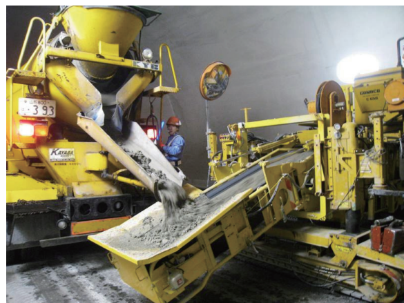
写真-5 ベルコン材料横取り状況
