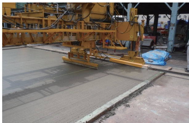
写真-10 試験施工状況
