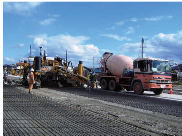
写真-2 施工状況（打設）
