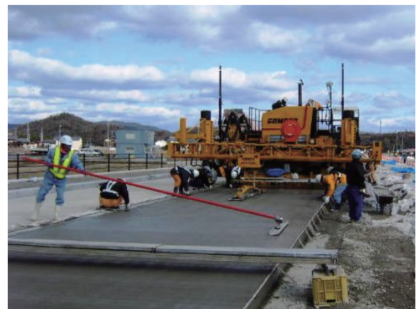
写真-3 施工状況（表面仕上げ）
