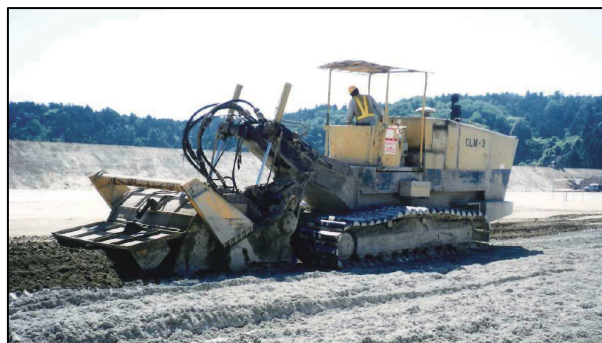
写真-3 深層スタビライザによる混合作業
