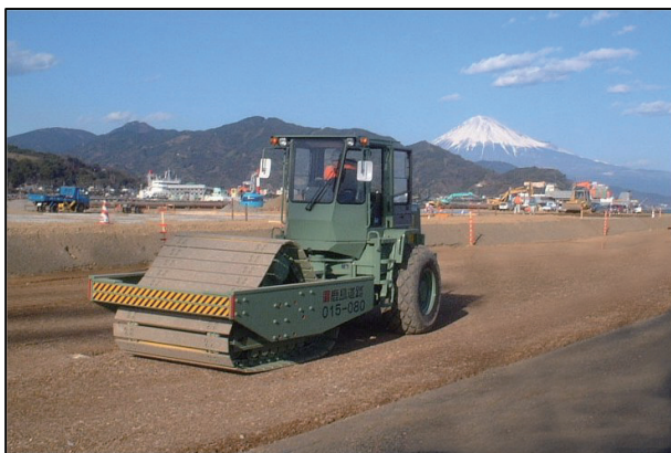
写真-2 クローラ式振動転圧機
