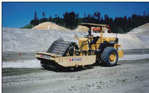
写真-4 クローラ式振動コンパクタによる締固め
