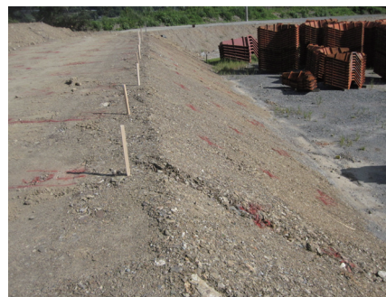
写真-1 現地での試験盛土の施工状況
