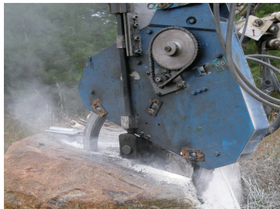
写真-3 切削状況
