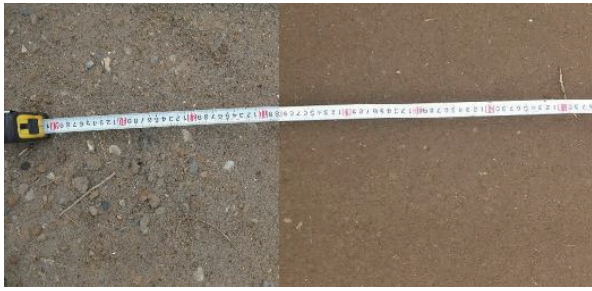
写真-10 左施工前 右施工後
