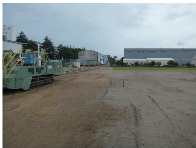
写真-9 施工前の現場の様子
