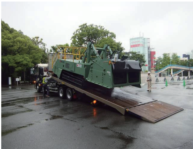
写真-3 セルフローダ搭載の状況
