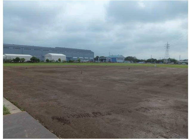
写真-13 施工後の現場
