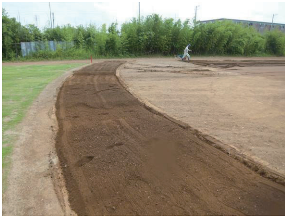
写真-11 曲線部の施工
