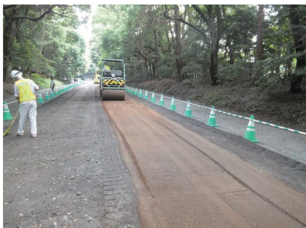
写真-7 左=施工前 右=攪拌・転圧後
