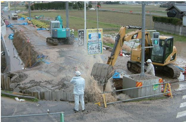
写真-1 水道管損傷事故
