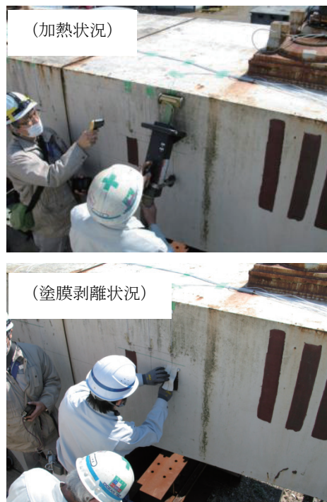
写真-3 塗膜除去試験状況
