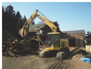
建設機械による解体作業
