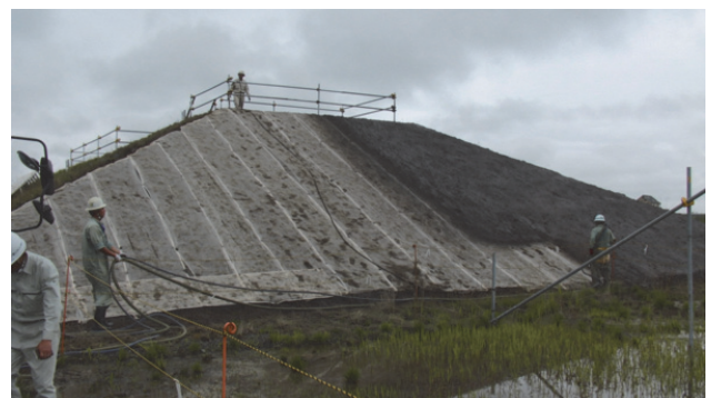
写真-10 緑化工事の様子
