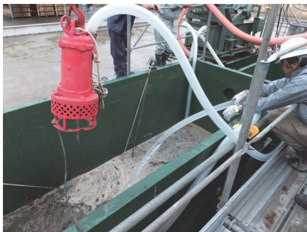
写真-3 津波堆積物に加水している様子
