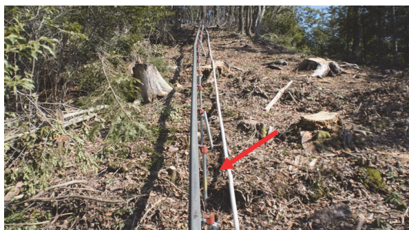
写真-4 光ファイバケーブル敷設状況
