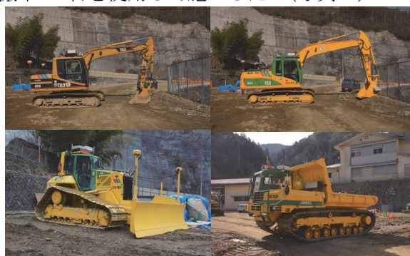
写真-2 北股地区河道閉塞緊急対策工事使用建設機械
