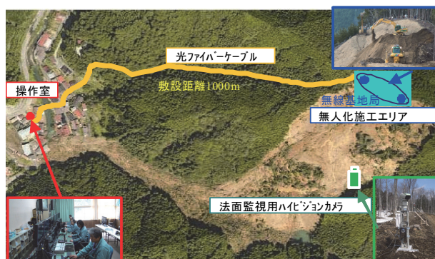
図-5 北股地区河道閉塞緊急対策工事仮設配置
