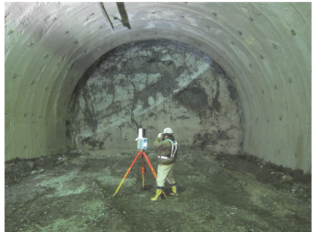
写真-2 坑内計測状況
