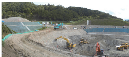
写真-4 北坑口部切土工状況
