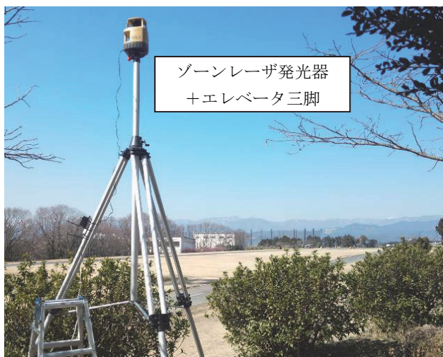
写真-1 ゾーンレーザ発光器設置状況
