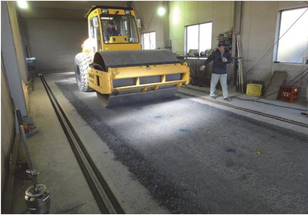
写真-1 SV512による転圧・計測状況
