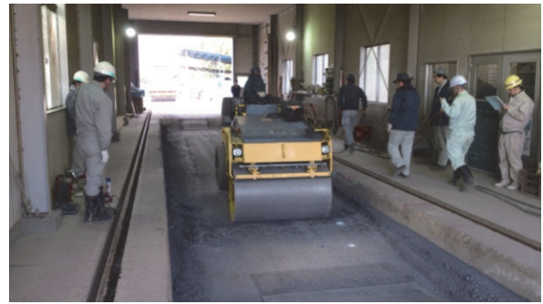
写真-1 大型土槽実験の状況(TW502)
