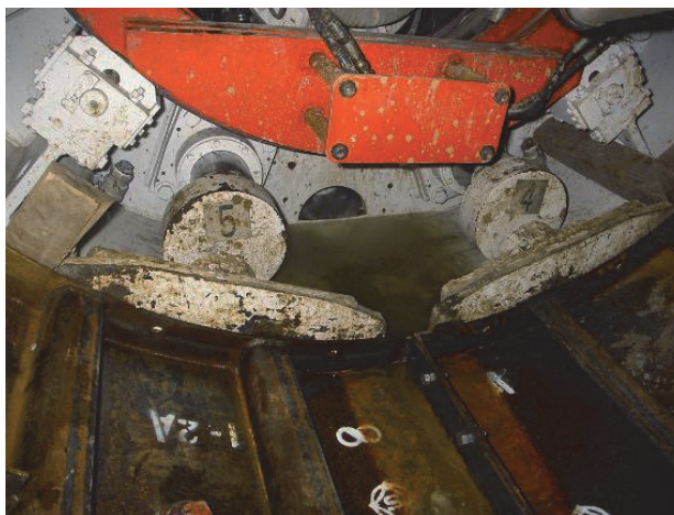
写真-7 シールドマシンテール部状況(地下水流入)
