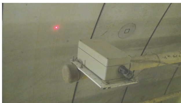
写真-2 レーザー距離計計測状況
