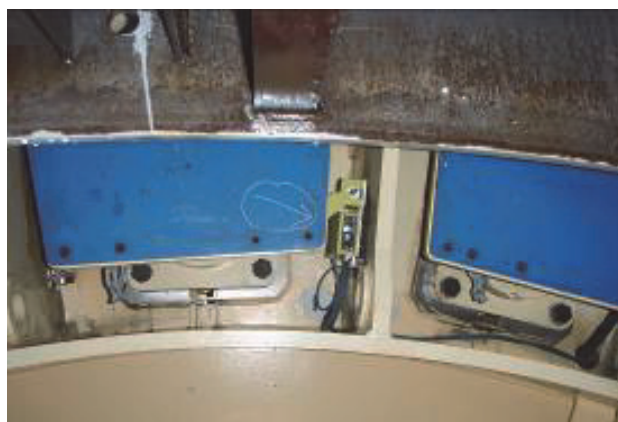
写真-8 計測ユニット設置状況
