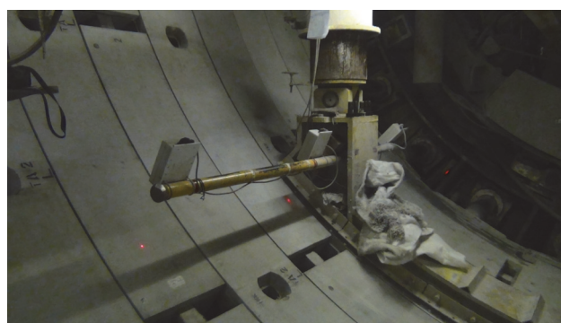
写真-11 真円度計測システム稼働状況(下部側)
