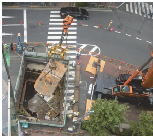
写真-7 マシン引揚状況
