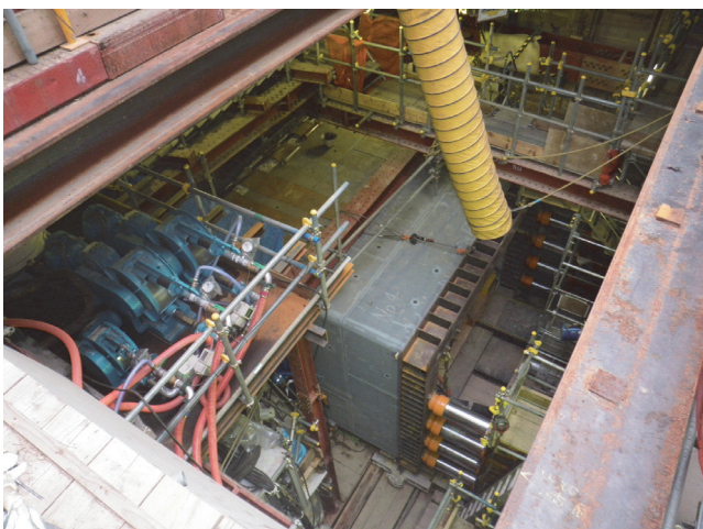
写真-5 発進立坑内設備配置状況
