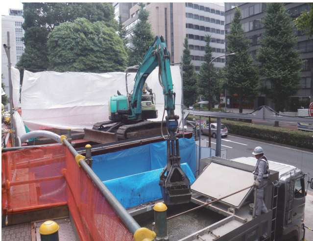
写真-4 発進立坑汚泥搬出状況
