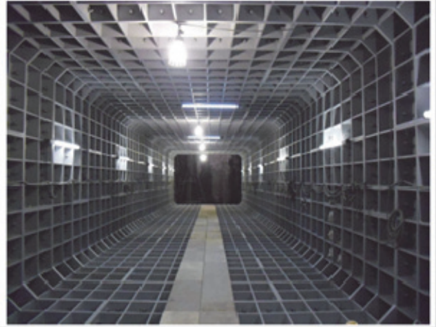
写真-10 トンネル一次覆工完了状況
