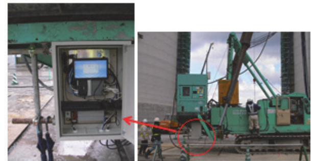
写真-2 地盤評価PC取付け状況
