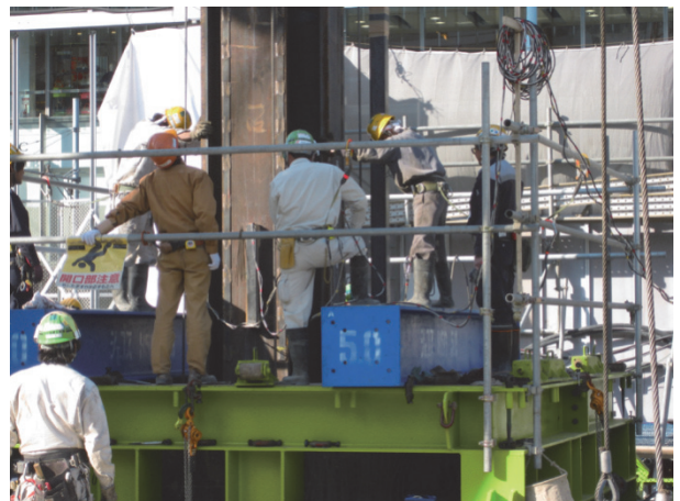
図-10 傾斜計のセット
