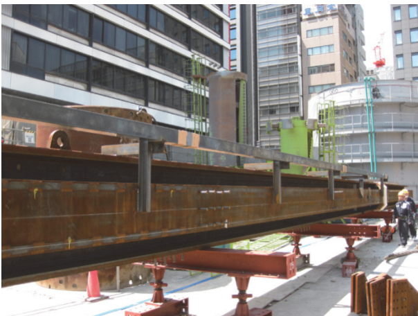
図-8 ガイド管の取付け
