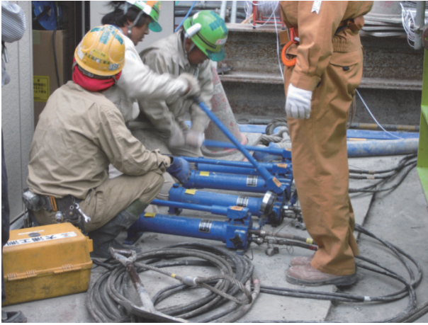
図-12 ジャッキによる建入れ調整
