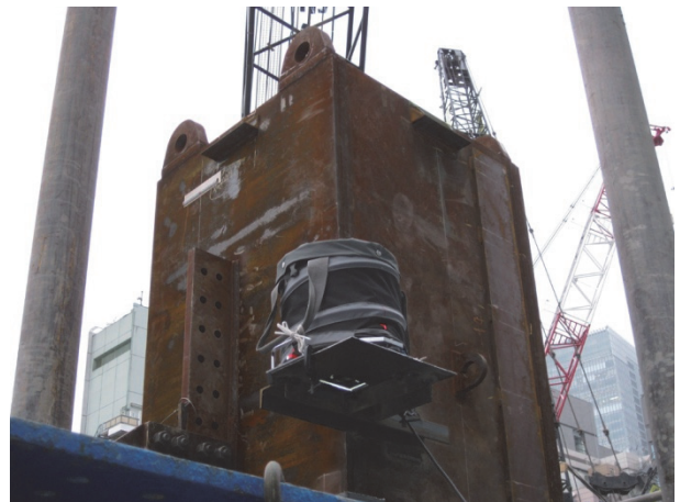
図-11 カメラユニットの設置
