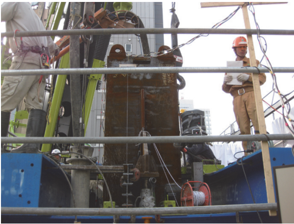
図-13 コンクリート打設中の建入れ計測
