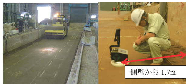
写真-3. 大型機械走行状況と密度測定状況
