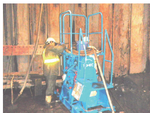
写真-4 防護注入
