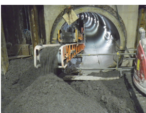
写真-13 土砂仮置き
