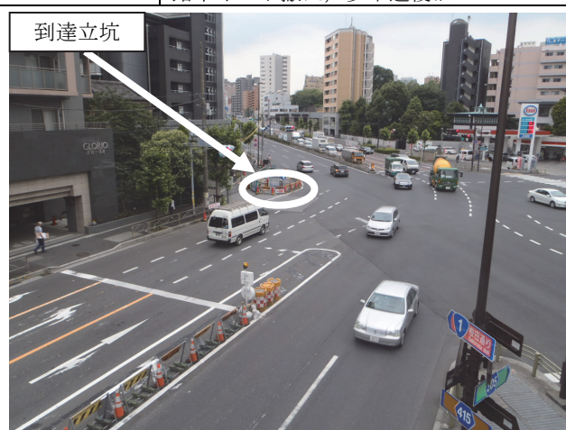
写真-1 到達立坑周辺状況
