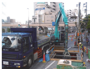
写真-3 立坑地上掘削
