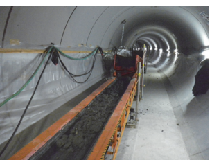
写真-12 管内土砂搬送
