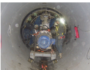
写真-7 機内設備撤去
