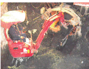
写真-11 立坑路下掘削
