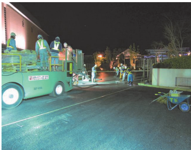
写真―11 ホテルエントランス外構改修工事（夜間）
