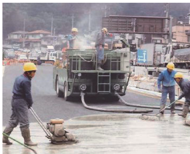
写真一1 従来の施工作業全景
