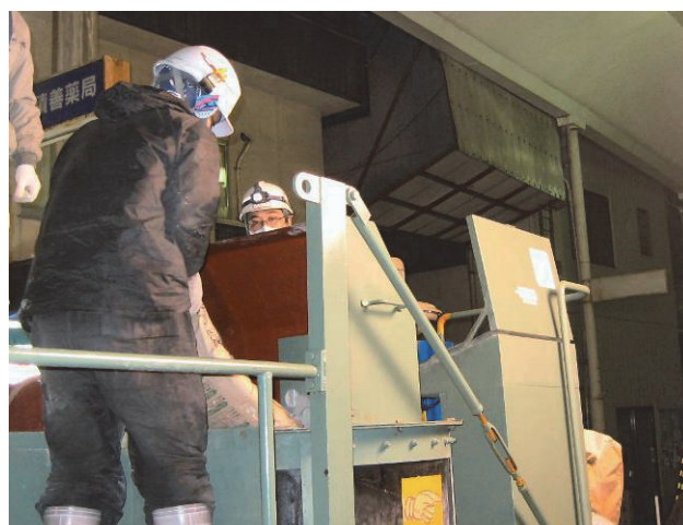
写真―７ ミキサへの投入作業
