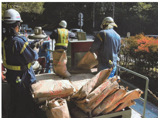
写真―10 ミキサへの投入作業
