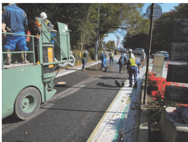
写真―9 一般道半たわみ舗装工事（昼間）
