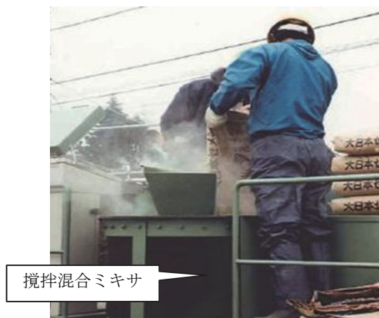
写真－３ 従来のセメント投入作業
