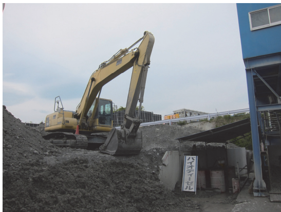
写真-3 BDF を使用した建設機械
