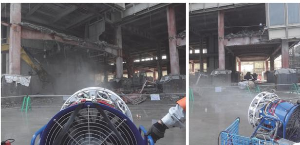
写真-2 マイクロECミスト適用状況
