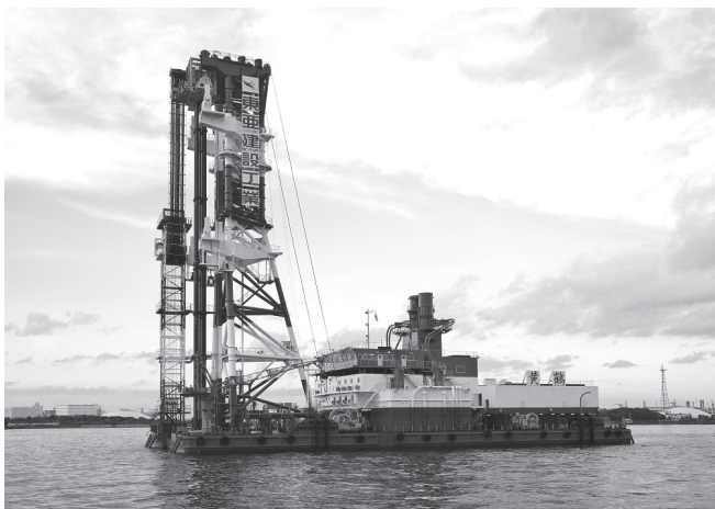
写真-1 環境配慮型深層混合処理船 黄鶴
