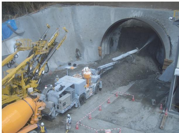
写真-2 坑口部の吹付け状況
