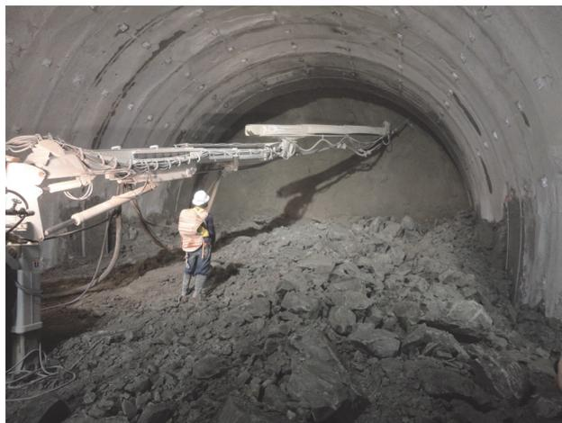
写真-3 堆積ズリ後方からの吹付け作業
