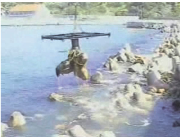
図-3 網チェーンによるブロック撤去作業
