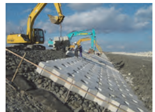
2割の法面に位置付けられたブロックを高さ・勾配・位置の微調整をしながら据え付けていく(斜吊り)
