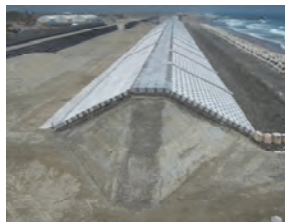
竣工(堤防全景・終点側上空より)
