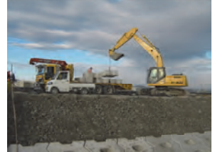
ブロックの荷吊り状況(水平吊り)
