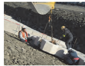
2割の法面に位置付けられたブロックを高さ・勾配・位置の微調整をしながら据え付けていく(斜吊り)
