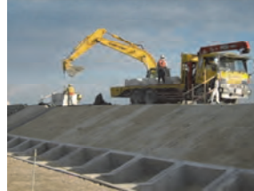
据付箇所への仮置き状況(水平吊り)
