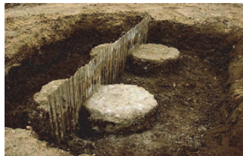
写真-3 鋼矢板との密着状況
