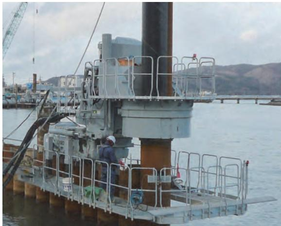
写真-7 鋼管杭施工状況
