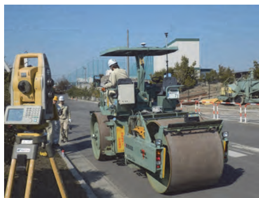
写真-9 試験状況写真
