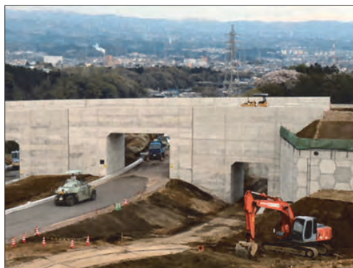
写真-5 高速道路ジャンクション工事例
