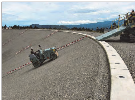
写真-4 ダム・ため池舗装工事例
