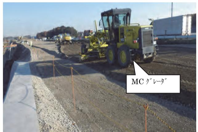
図-10 下層路盤の敷均し状況(MC グレーダ)
