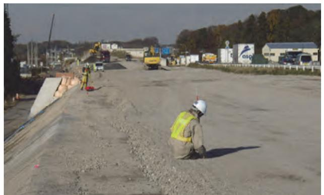
図-11 下層路盤の出来形計測状況
