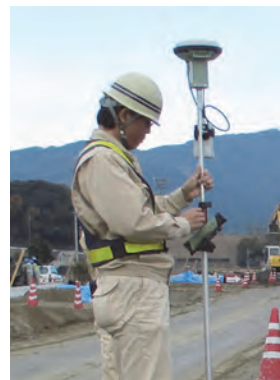
図-8 施工現場における GNSS 測量
