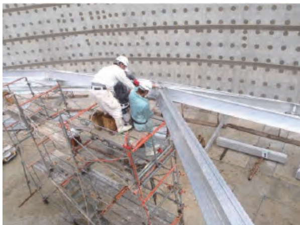
写真-2 従来工法での組立状況
