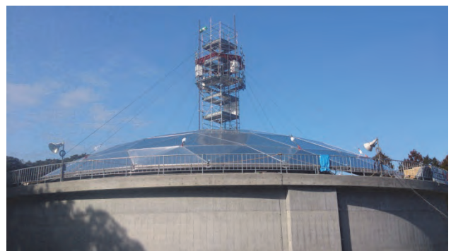
写真-6 FCF システムによる吊り上げ完了
