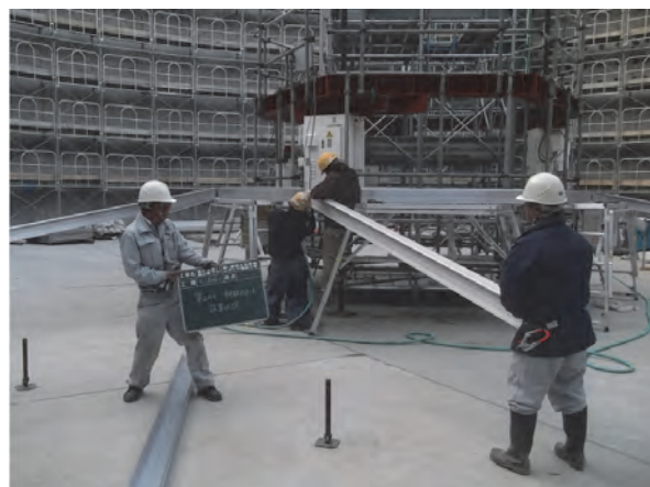
写真-3 中心からの組み立て状況
